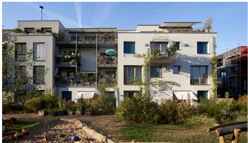
Abb. 10: Passivhaus, Fassadenansicht des Projekts „Wunschnachbarn“ in Köln (©MHKBD NRW/Veit Landwehr, Köln)
