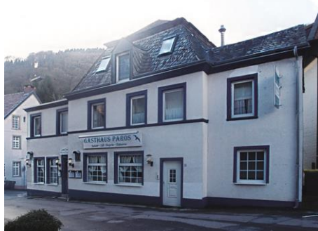
Abbildung 5: Immobilie für das neue Begegnungszentrum in Altena (Quelle: eigene Aufnahme)
